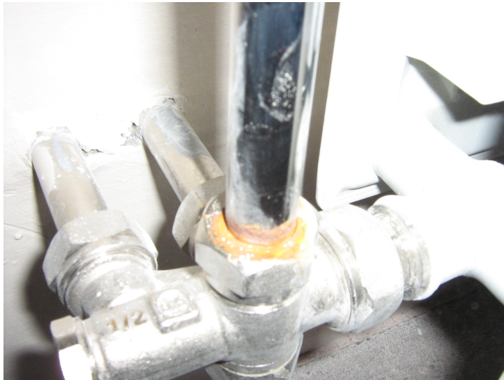
Foto van bout met roest in slaapkamer 1.
